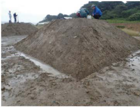
DWファイバーの混合量を変えた試験盛土
