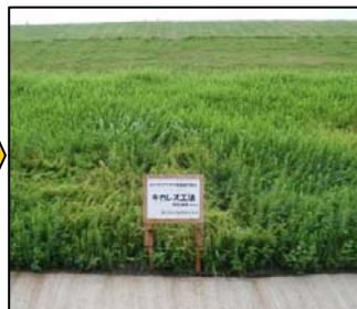
▲施工6ヶ月後 在来植物に植生転換した法面
